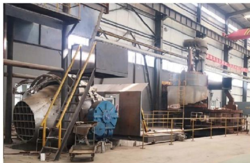
8吨AOD精炼炉 Horno de refinación AOD de 8 toneladas.
